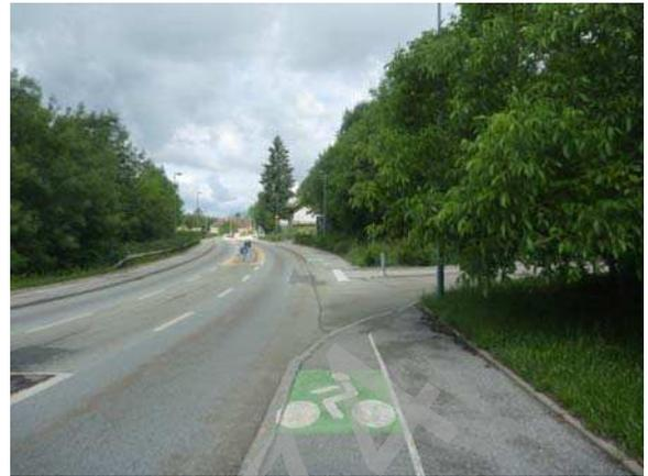
La continuité du revêtement est essentielle pour ne pas engendrer de risque de chute ou d'accident; sur la photo jointe, prise sur la D907 à Vétraz- Monthoux, la disparité des revêtements de cette piste installée sur un trottoir n'incite pas les cyclistes à l'emprunter. La seule bande blanche ne suffit pas à distinguer les besoins des piétons et des cyclistes. Dans le chapitre cheminements mixtes, nous reprendrons cette analyse.
