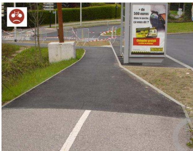
L'implantation d'un abribus a rogné sur la piste bidirectionnelle avant le giratoire intermédiaire.
