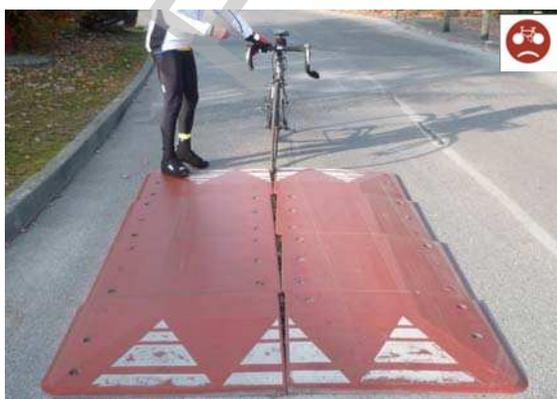
Ces coussins sont réalisés soit en béton préfabriqués - éléments ancrés sur la voirie - ou en matériaux de synthèse, assemblés. **La FFCT demande la suppression de ces derniers** qui présentent de nombreux risques de chutes: soit par glissement des pneus soit par création d'espaces entre plaques suite à leur désolidarisation de la chaussée sous l'effet des sollicitations liées au trafic.
