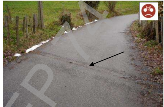
Goulotte d'écoulement non balisée à St Sylvestre ayant entraîné un accident
