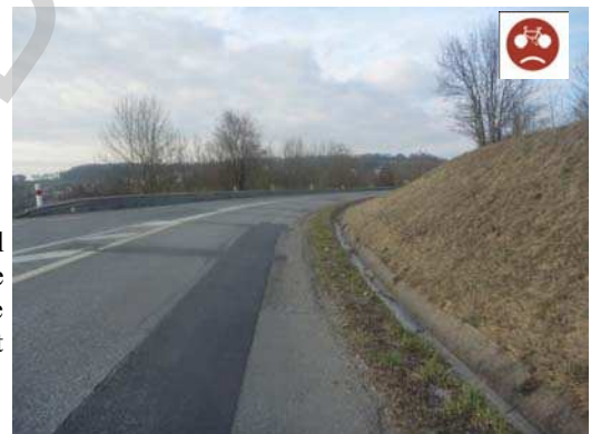
Goulotte d'écoulement non balisée à St Sylvestre ayant entraîné un accident
