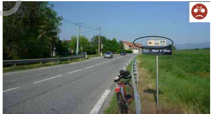
Accès à la véloroute du Léman à la mer près de Valleiry, sur le CD 1206 Tourne à gauche peu sécuritaire pour les cyclistes
